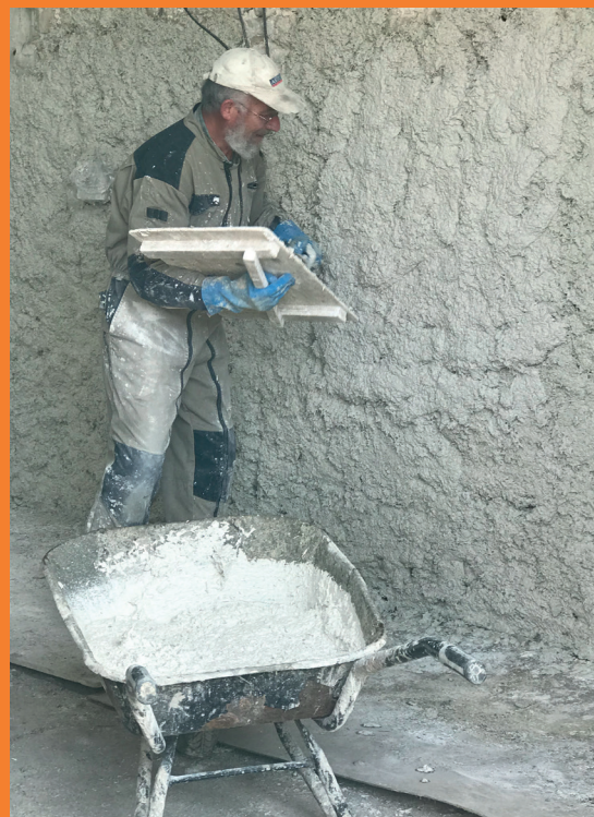
Application première couche d'un enduit chanvre.
