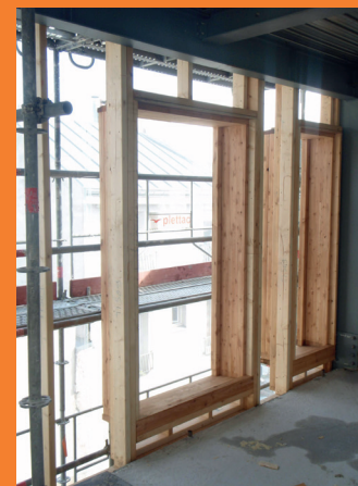
Précadre avant à gauche. Précadre dans mur fini en haut.
