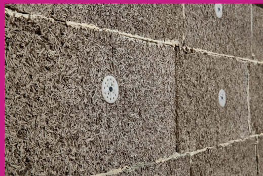
Fixation de doublage en blocs de chanvre avec chevilles pour isolants.
