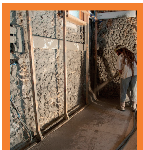
doublage de mur ancien - règles de guidage d'épaisseur
