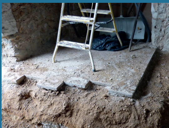
Sol ancien, posé sur terre-plein, sans dalle.
