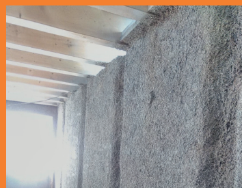
Règles de guidage incluses l'épaisseur à projeter. Règles enlevées, rebouchages à faire.
