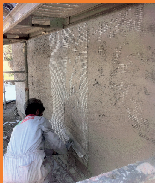
Chantier enduit finition.
