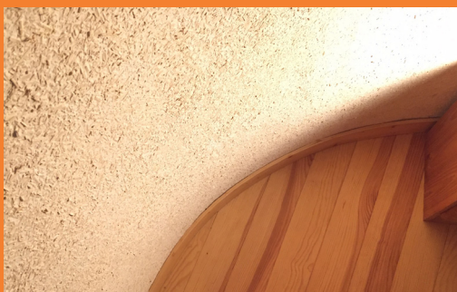
Enduit chaux chanvre qui permet de traiter facilement les arrondis.
