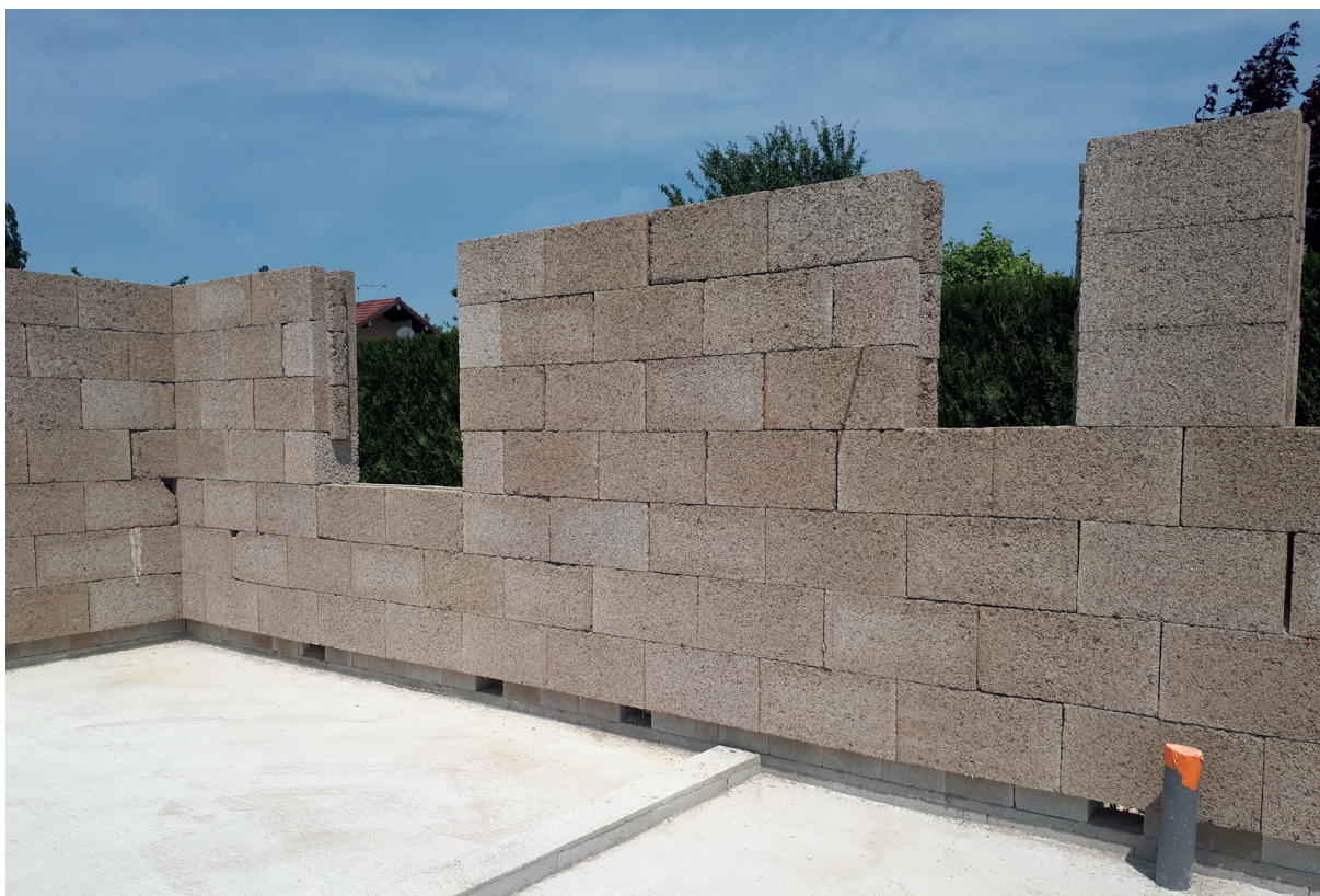
Construction Blocs de chanvre à emboîtement.
