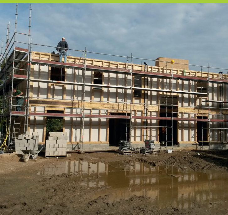
Les ouvrages en béton de chanvre doivent être protégés de la pluie.
