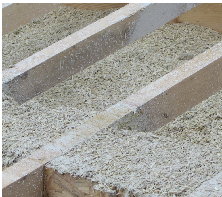
Béton de chanvre mis en œuvre en toiture
