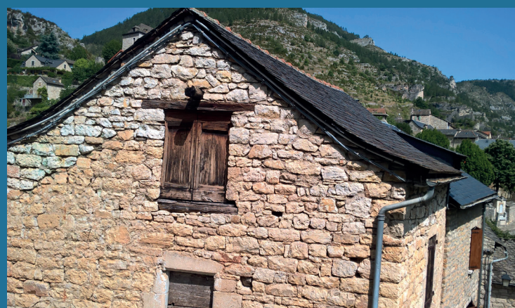
La bâti ancien a subi des transformations : il a été adapté.
