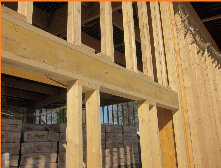
Ossature externe avant pose du coffrage
