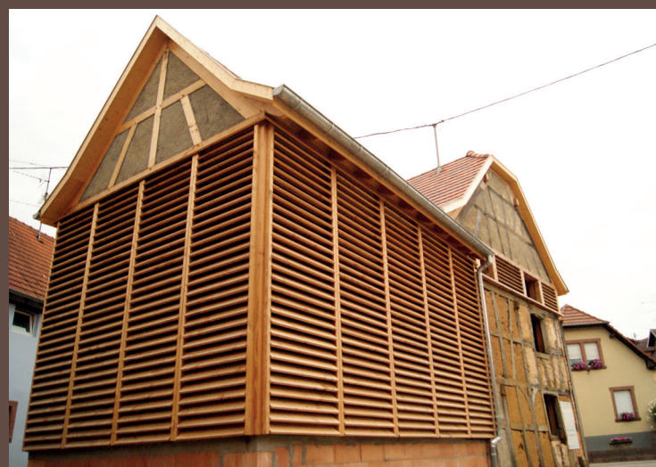
Réhabilitation d'un bâtiment en colombage en Alsace.
