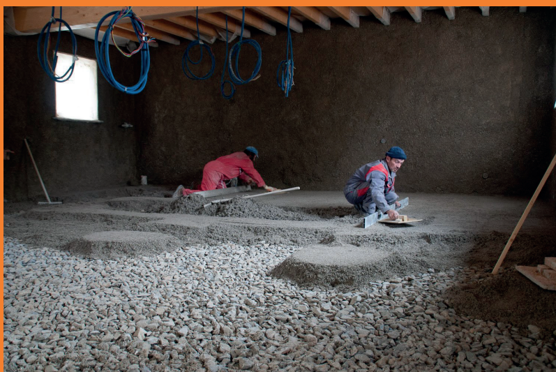
Chantier isolation de sol.
