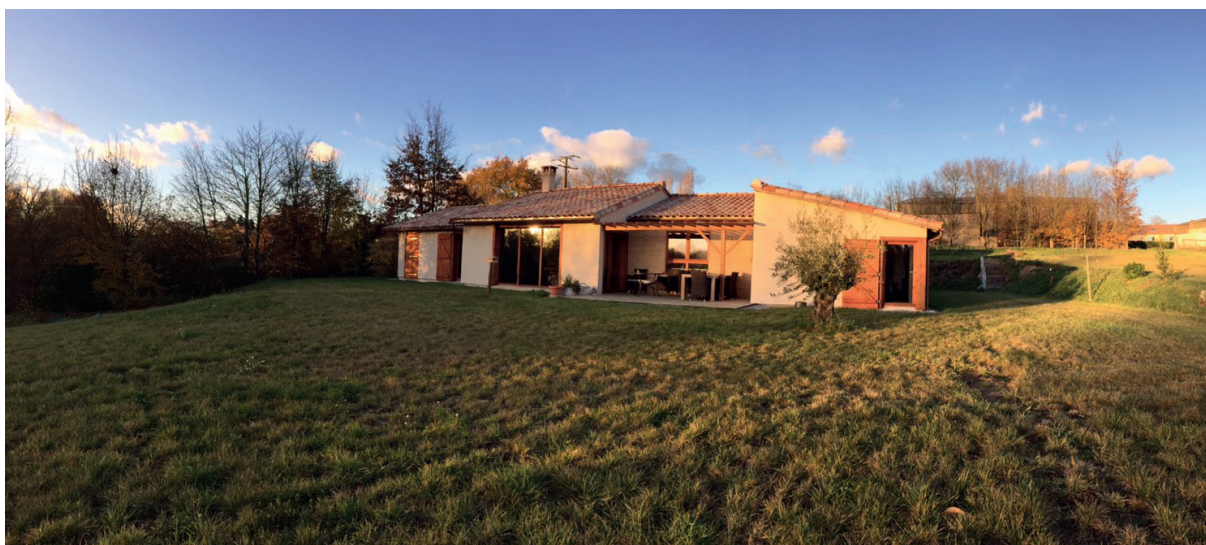
Vue d'ensemble d'une maison entièrement en chanvre ossature bois.
