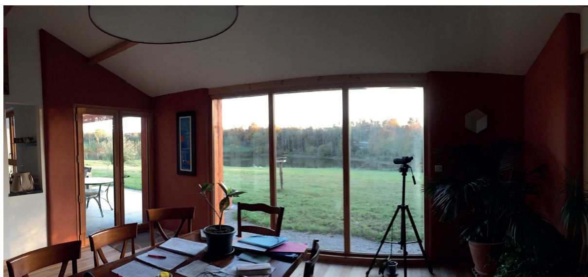
Enduit chaux chanvre mur et plafond.
