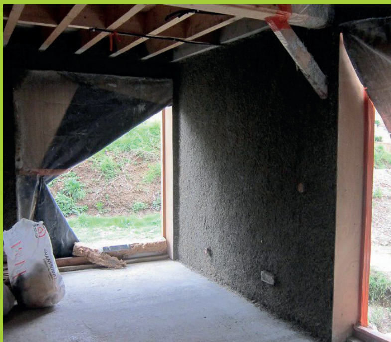
La ventilation est nécessaire au bon séchage des ouvrages en chanvre.
