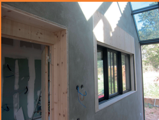
Chantier enduit finition.
