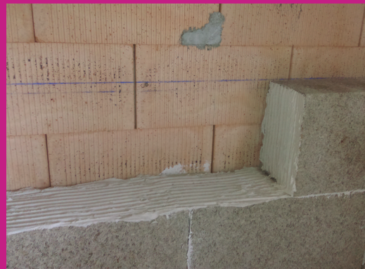
Doublage isolant en blocs de chanvre.
