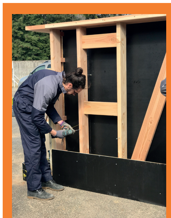
Pose coffrage en contreplaqué filmé.
