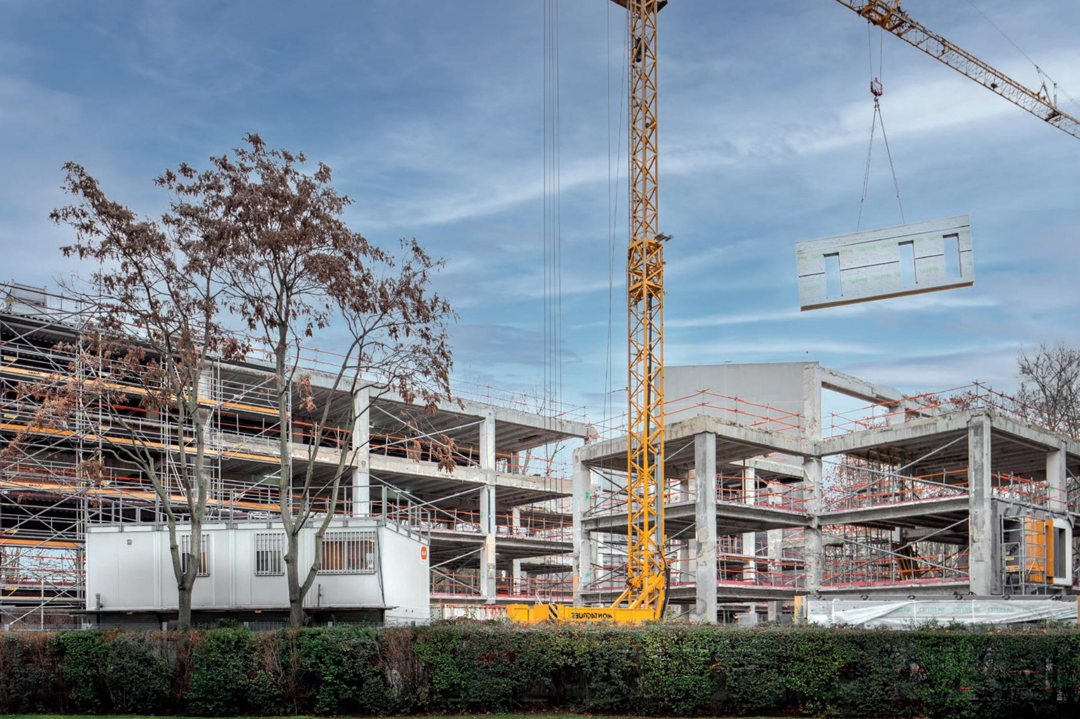
Pose d'un caisson bois-paille fermé sur l'ancienne structure béton.
